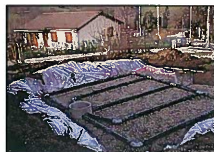
. Contrôle de l'assainissement non collectif
